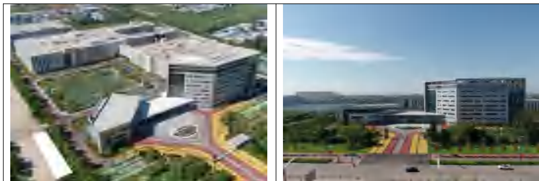
图 3.2-5 厂区及车间内部图片
